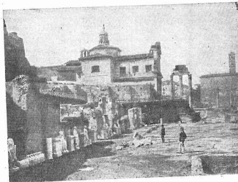
Estado actual del Foro romano
